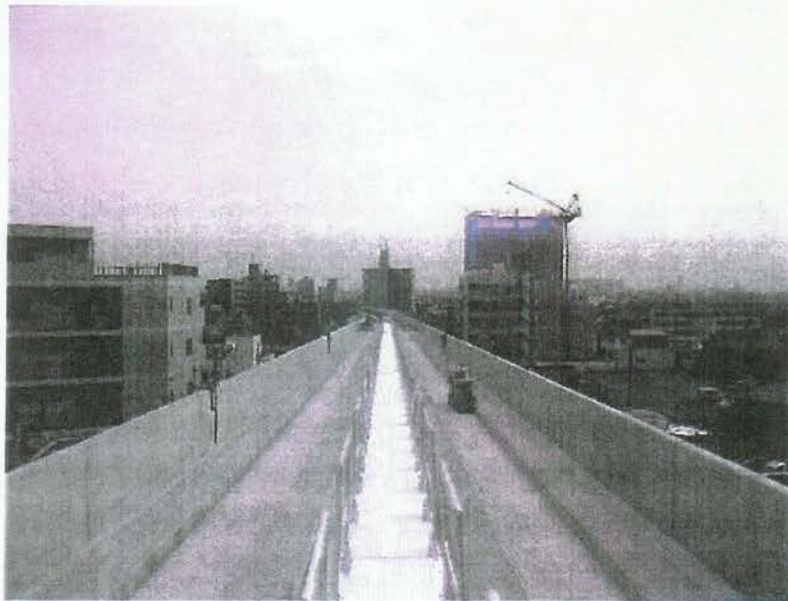
東京都日暮里・舎人線上部仕上げ工事
