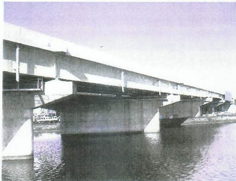
北陸地方整備局新川橋高架橋
